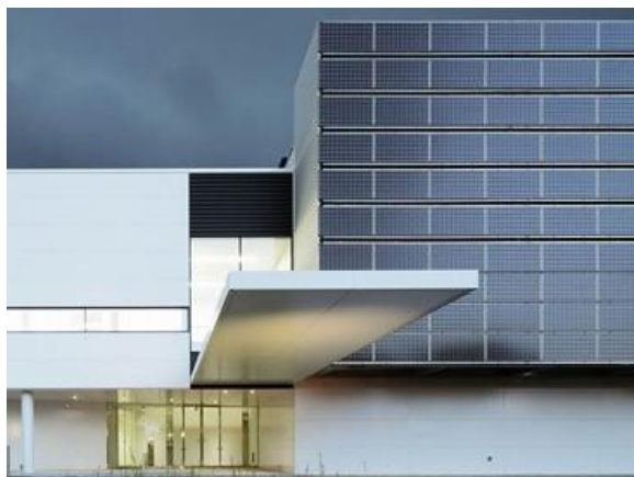
日除け兼用の太陽光パネル
