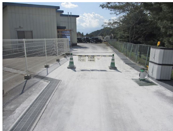
図2 消石灰帯および入構制限
