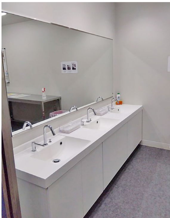
写真5-1 入口の手洗い場
