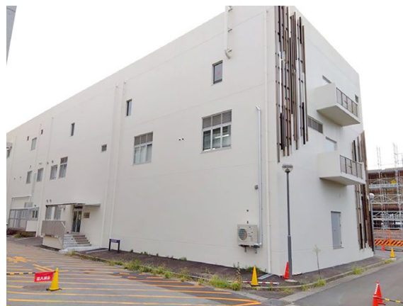
写真3-2 第Ⅲ期施設 3棟が繋がった構造になっています。
